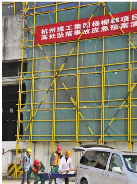
为进一步提高项目部对突发事件的应急处置能力,12月16日集团公司应市
