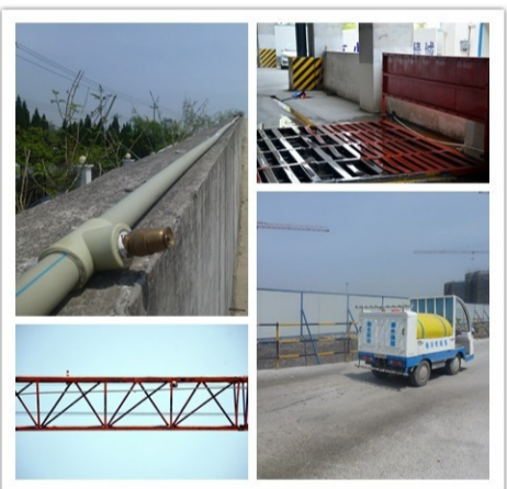
图:左上为道路喷淋,右上为净车自动冲洗系统,左下为塔吊喷淋,右下为洒水电动车。
