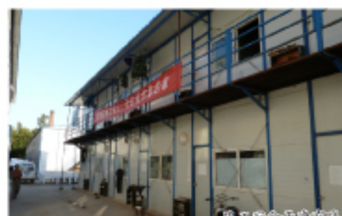
项目部的施工现场
